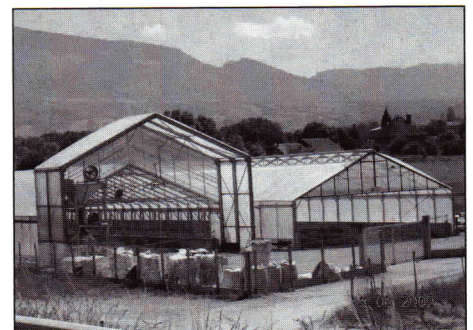
Serre de séchage du syndicat de Bellecombe
